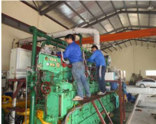
Hình 1. Hệ thống cấp nhiên liệu cho động cơ Hanshin 6LU32
