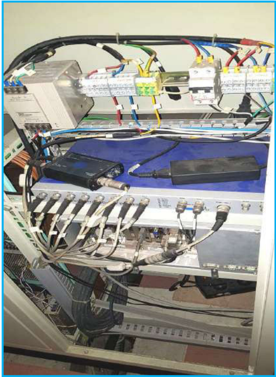
Hình 10. Các đầu kênh tín hiệu từ Rơ le truyền về hệ thống thiết bị kết nối máy tính trung tâm
